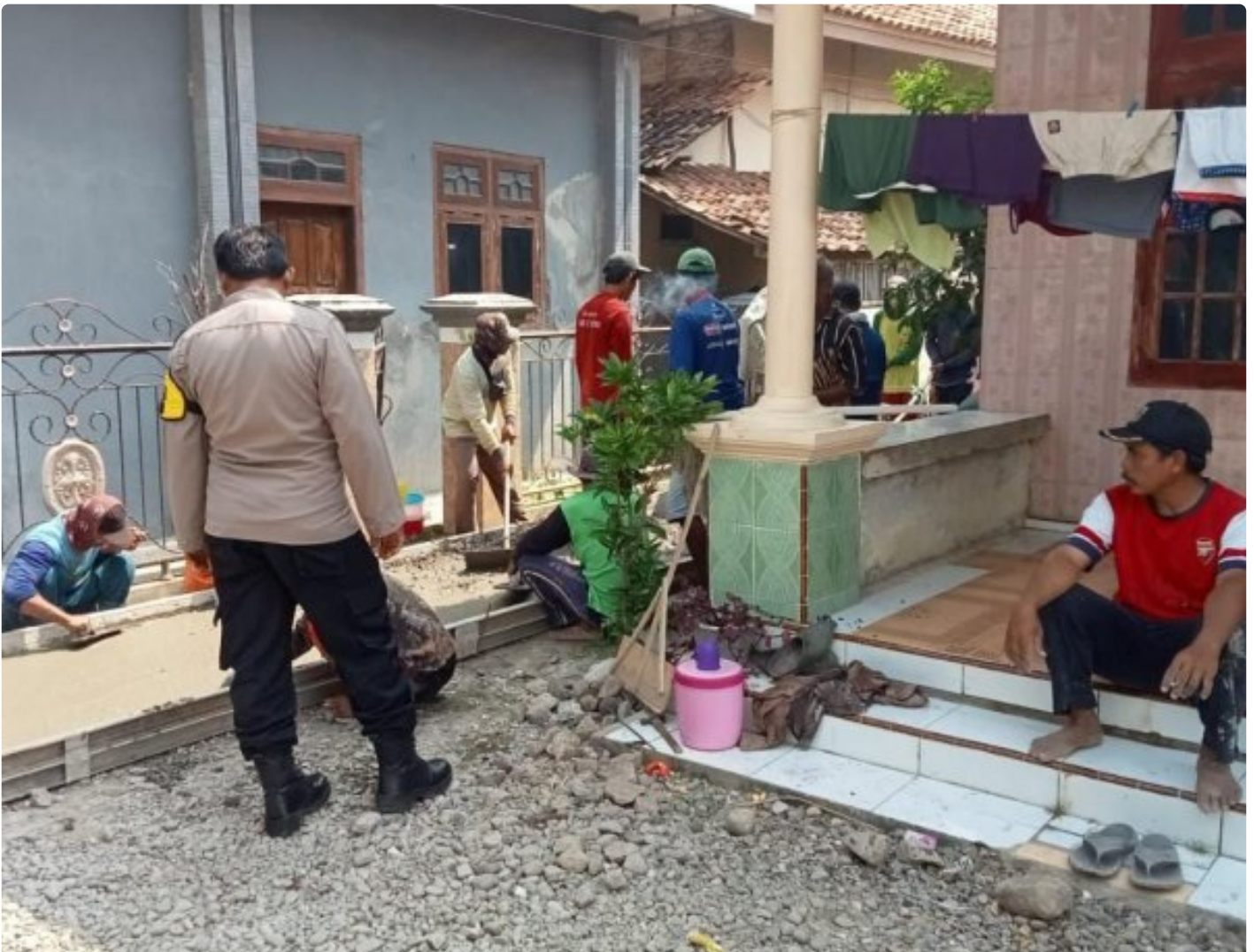
Bhabinkamtibmas Polsek Lohbener Memantau Progres Pembangunan Jalan Setapak
